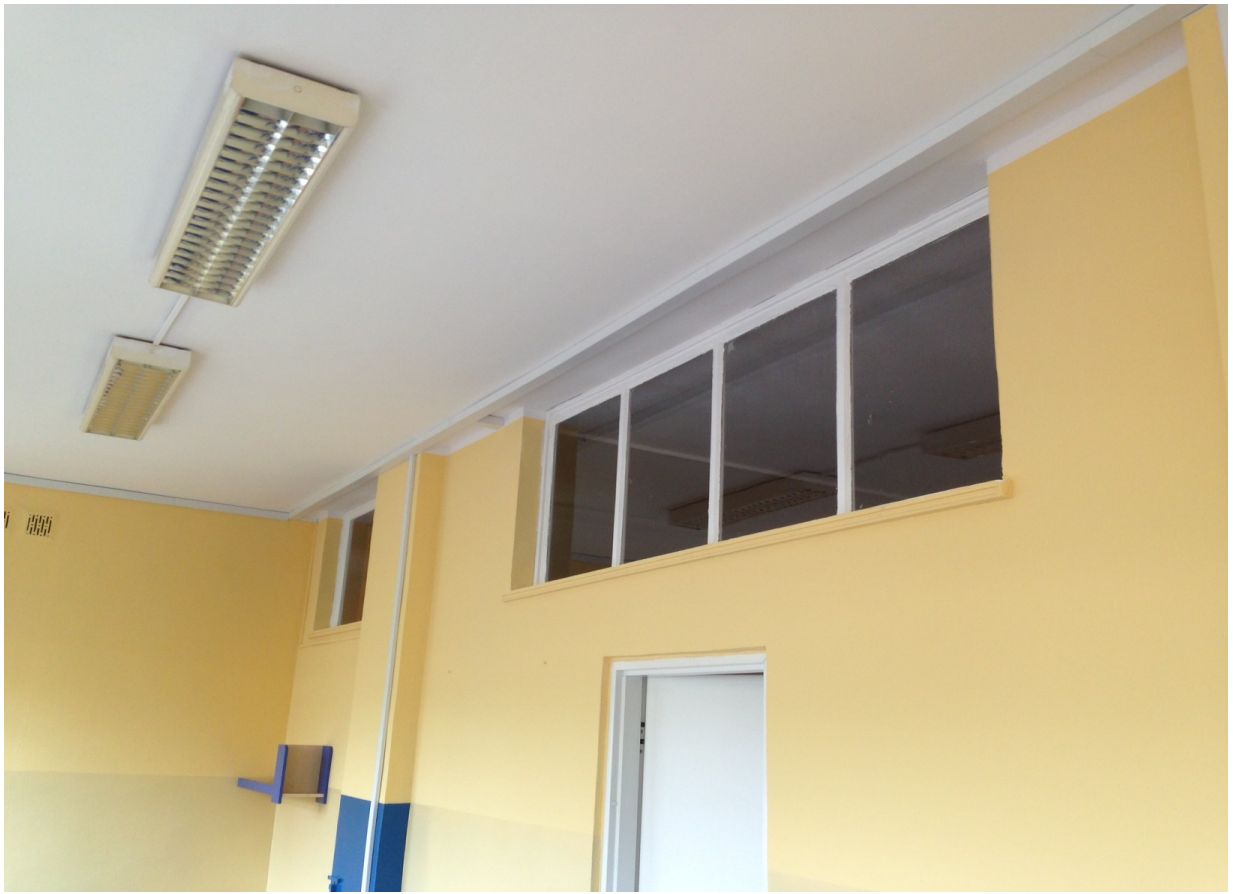
Odrestaurowane futryny okienne
